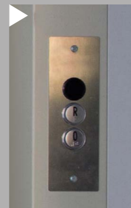
BOTTONIERA DI PIANO A PIASTRA IN ACCIAIO INOX CON PULSANTI BRAILLE DI CHIAMATA ED INVIO
