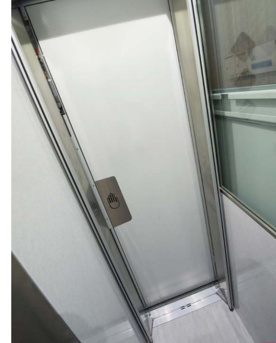
PORTE DI CABINA A SOFFIETTO AUTOMATICO E FINITURA ACCIAIO INOX
