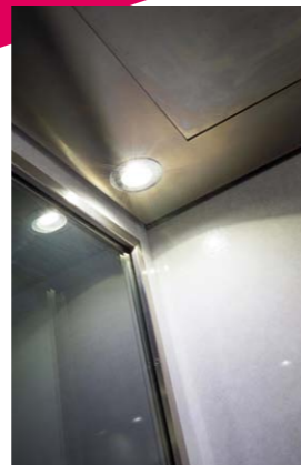
ILLUMINAZIONE CON CIELINO IN ACCIAIO INOX E FARETTI A LED
