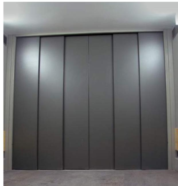
SpaceQuby è dotato di fotocellula a barriera infrarossi. In questo modo le porte non si chiudono (se automatiche) in presenza di un ostacolo e la cabina non si muove in caso di SpaceQuby senza porte in cabina.
